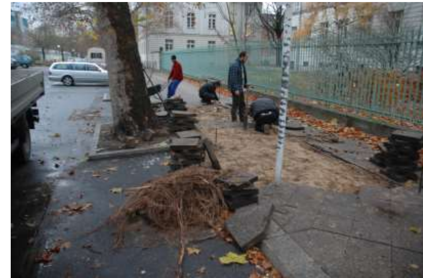
Belagsschäden: Wurzelkappungen
