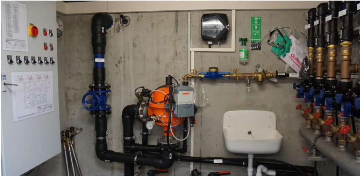
**Kombination eines Schachtbauwerkes für Springbrunnentechnik mit Bewässerungstechnik**
